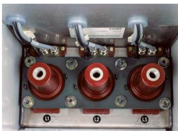
Рис. 40. Комбинированный сенсор.
