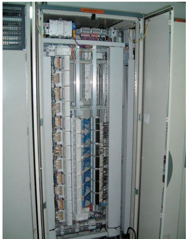
**Bild 5: Kabinett mit S800 I/O System, rahmenmontiert**
