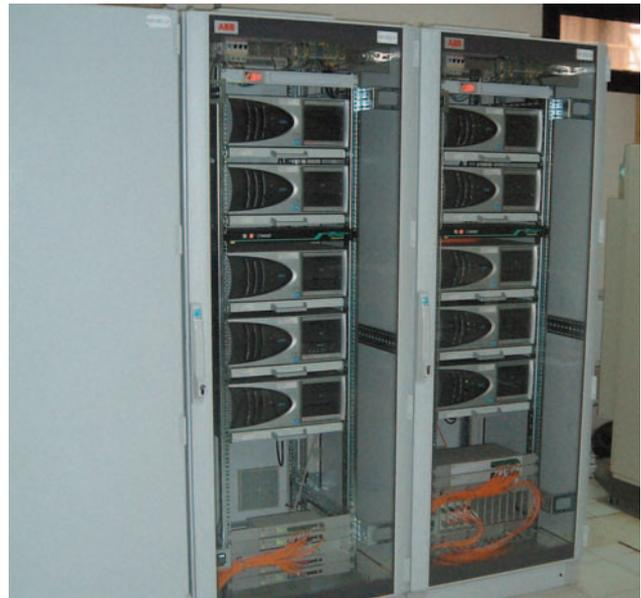
**Bild 4: „Connectivity und Aspect Server“, rahmenmontiert**
