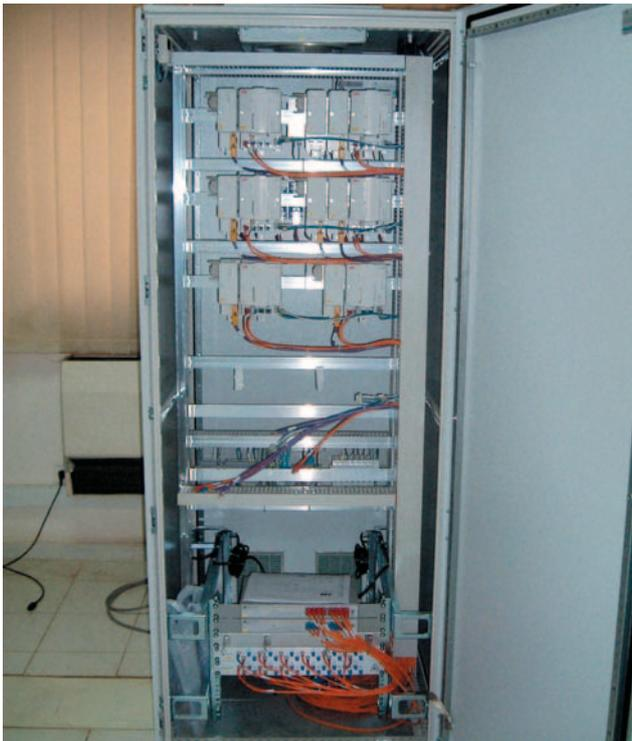
**Bild 3: ControlIT-AC800M Controller**
