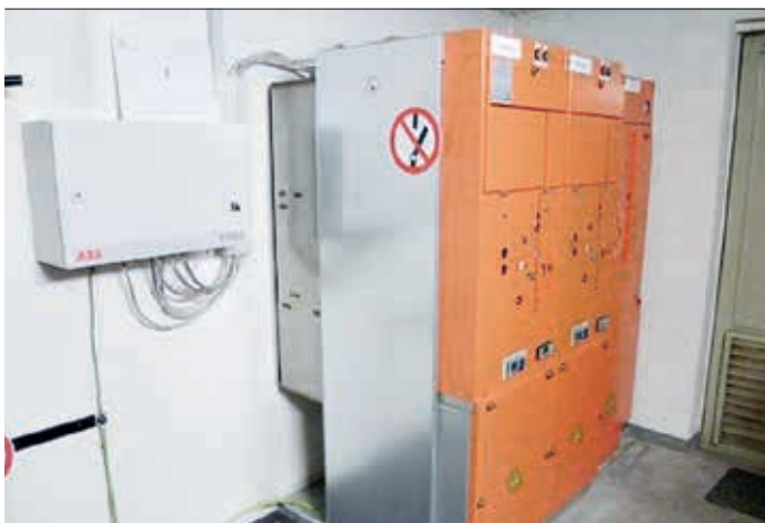
4c Sustitución de aparatama existente en una subestación visitable
