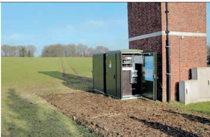
4b Solución con armario especial con nueva aparatama e "inteligencia" añadida a la subestación existente
