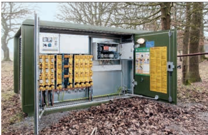
4a Nueva subestación compacta inteligente
