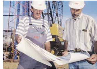
基础设施：防雷接地，照明系统，布线，通信系统和防火
