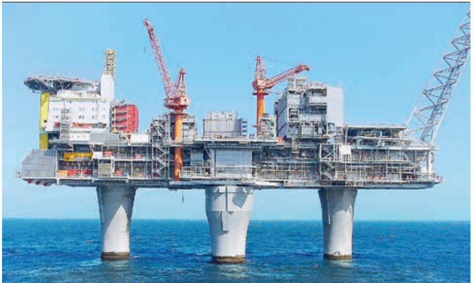
2 Station HVDC Light (en gris, entre les grues) sur la plate-forme Troll A, au large des côtes norvégiennes
