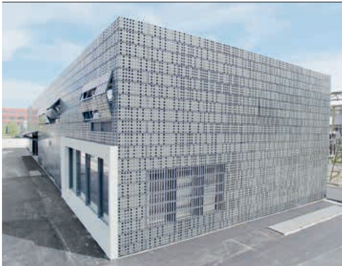
5a El edificio de la subestación de Oerlikon
