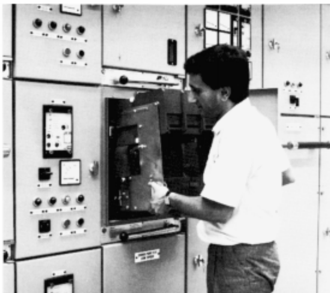
Fig. 30 Sollevamento del carrello per inserzione rotelle posteriori Truck lifting for rear wheels insertion
