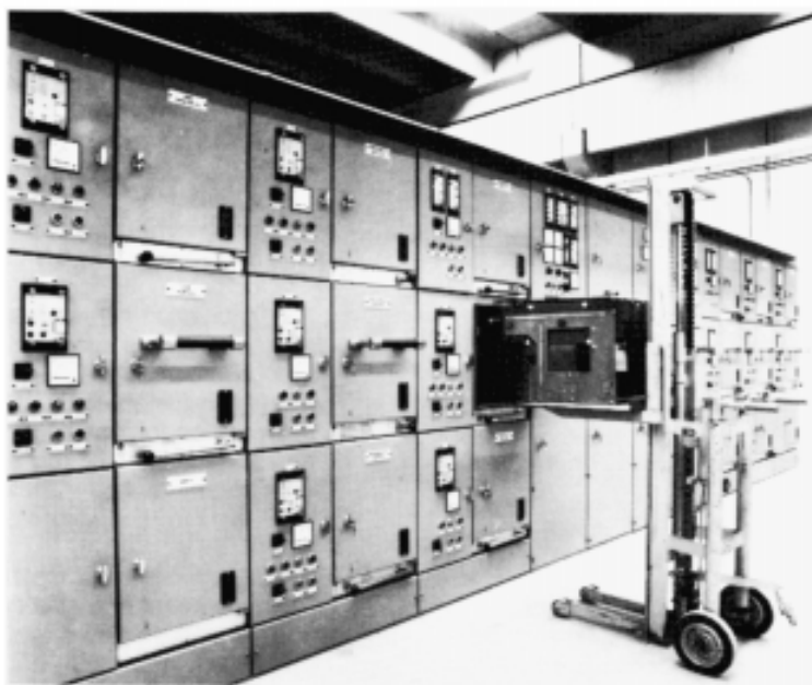
Fig. 27 Operazioni di trasporto, sollevamento e introduzione carrello
