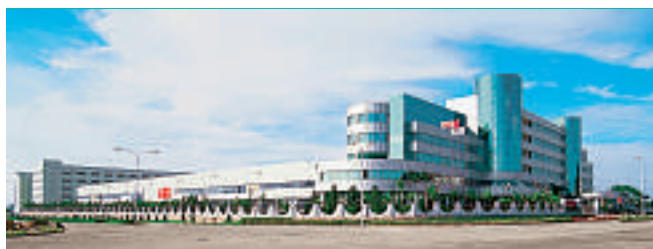
ABB Xiamen Switchgear Ltd., China
