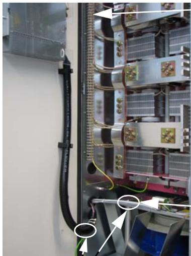
Для фиксации кабеля вентилятора используйте кабельные стяжки!
