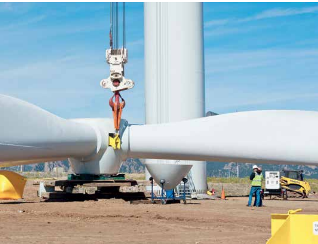
Montaż wiatrak z turbiną wiatrową o mocy 2 MW firmy Gamesa w należącym do NREL Narodowym Centrum Technologii Wiatrowych. (Fot. Dennis Schroeder/NREL, National Wind Technology Center – Colorado)
