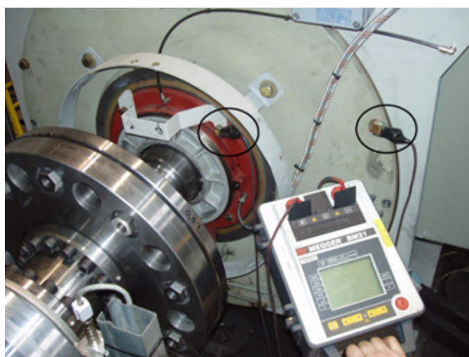
Figure 7-4 Mesure de la résistance d'isolation d'un palier à roulement
