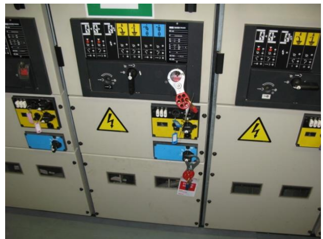
Figura 3. Panel bloqueado y etiquetado
