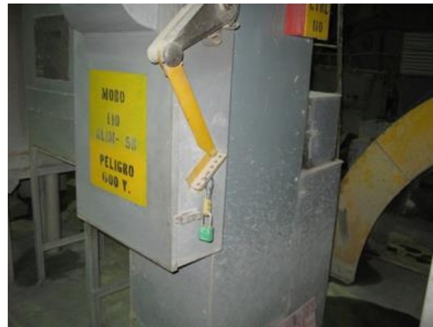
Figura 1. Bloqueo aplicado pero sin etiqueta
