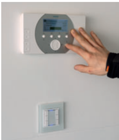
Die Synco living Wohnungszentrale als Bedien- und Kontrolleinheit, darunter ein KNX-Lichttaster.
