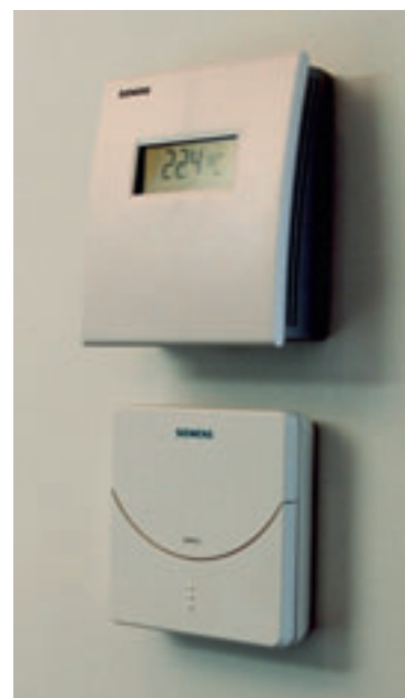
Luftqualität und Raumtemperatur werden per Funk an die Zentrale übermittelt.
