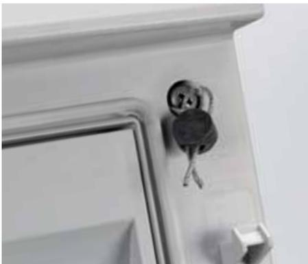
Si l'on souhaite rendre le coffret complètement inaccessible, il est possible d'utiliser des accessoires pour le plombage étanche du panneau frontal.
