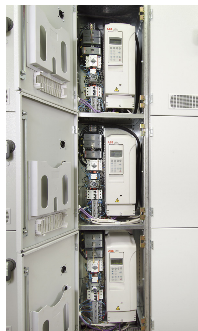
Частотные преобразователи, интегрированные в систему MNS.
