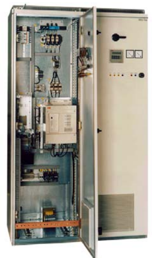
Montage en armoire
