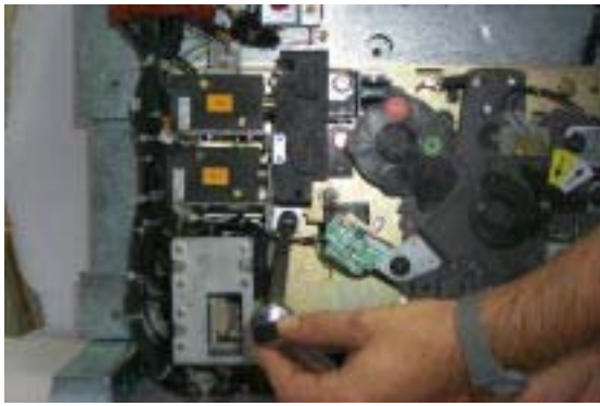
Svitare vite di fissaggio supporto gruppo sganciatori. Unscrew the fixing screw of the release group mount.
