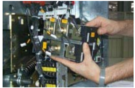
Estrarre il supporto gruppo sganciatori frontalmente al comando. Per il montaggio si procede in senso inverso. Withdraw the release group mount from the front of the operating mechanism. For assembly, proceed in reverse order.
