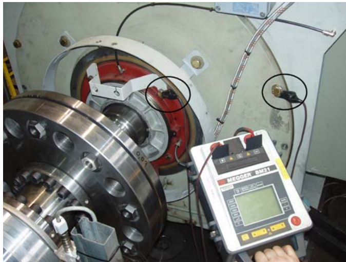
図 7-4 ローラーベアリングの絶縁抵抗を測定する
