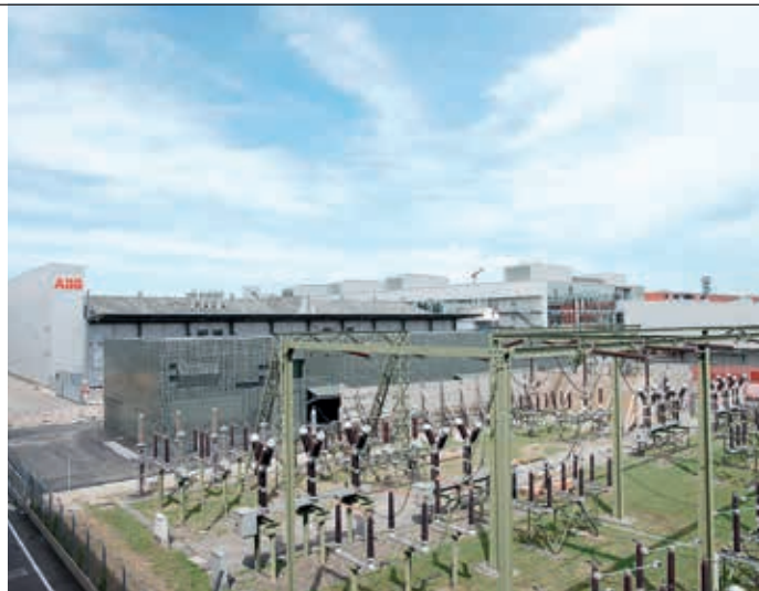
5b Usine d'appareillages GIS d'ABB, en arrière plan
