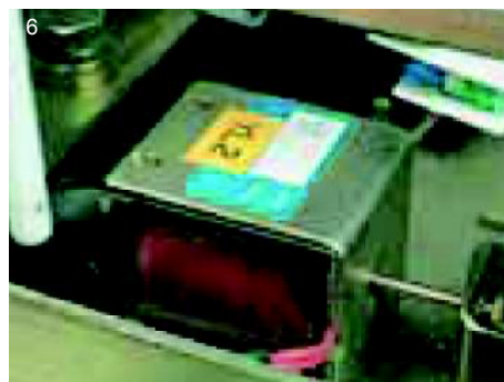
5 门闭锁装置 | 6 手车闭锁磁铁 | 7 不同额定电流的闭锁防护 | 8 电机驱动车手车
