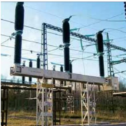
**6** Schaltvorgang bei Betätigung eines SF<sub>6</sub>-Leistungsschalters
