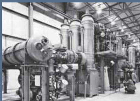
Leistungsschalter sind für den sicheren Betrieb eines Stromnetzes von entscheidender Bedeutung. Sie werden benötigt, um an Generatoren die gesamte Leistung eines Kraftwerks (im Gigawattbereich) ein- und auszuschalten und um in Unterstationen bei Spannungen von über 1.500 kV den Leistungsfluss in den Übertragungsleitungen zu lenken. Außerdem spielen sie eine wichtige Rolle in Verteilnetzen, wo sehr hohe Ströme bei mittleren Spannungen geschaltet werden müssen.
