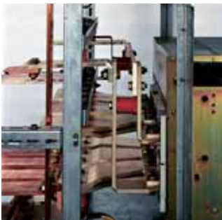
Esecuzione speciale kit di retrofitting OTOMAX P2C 3200 A neutro esterno con Emax E4 tetrapolare
