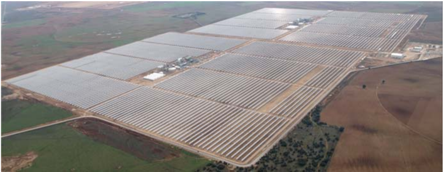
Planta termosolar de Manchasol, Ciudad Real
