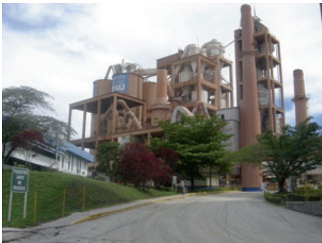
1 Itau de Minas plant 2 • Werk 2 Itau de Minas
