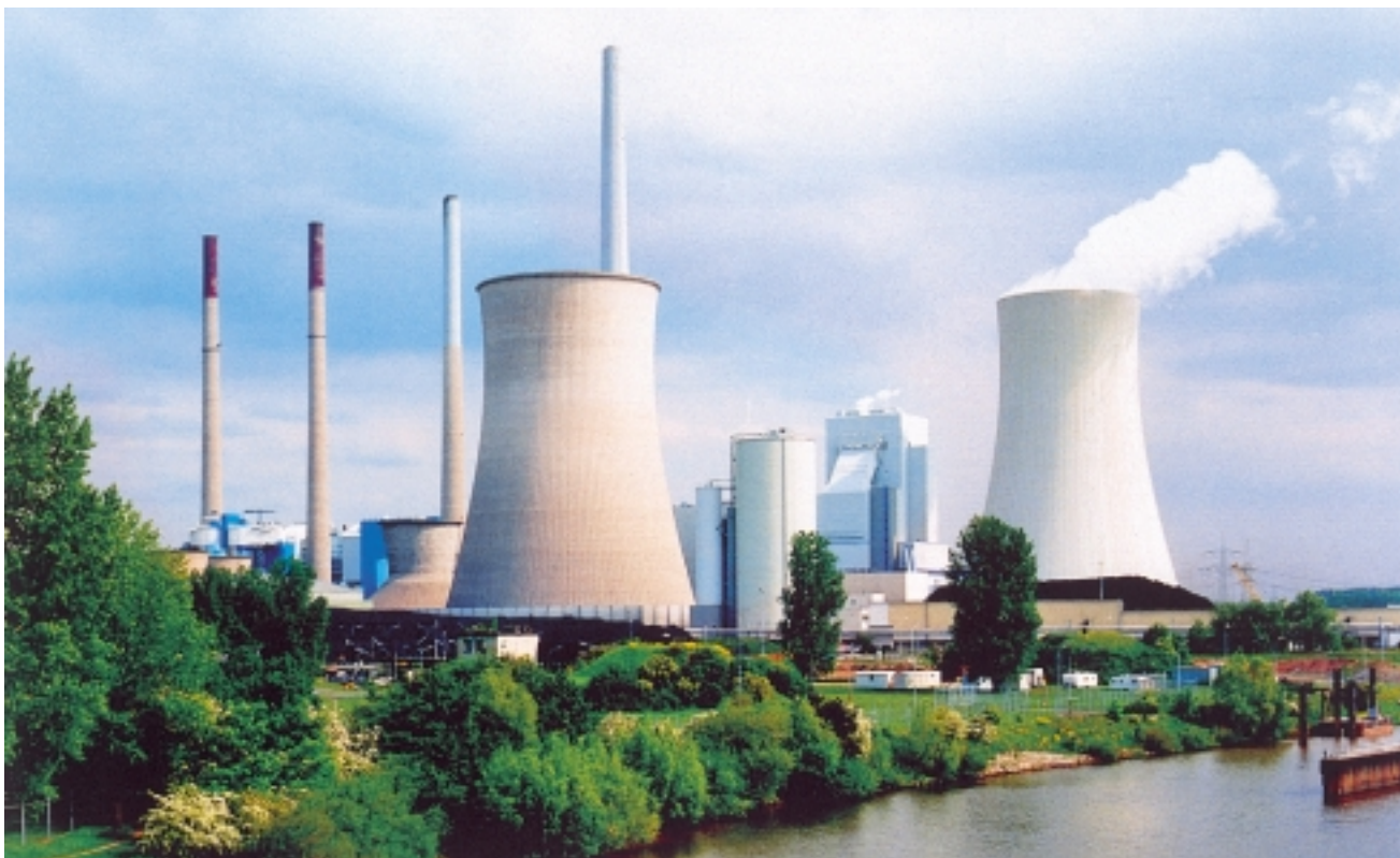
Rekonstruktion des 2 × 250-MW-Steinkohlekraftwerks Staudinger. Die gesteckten Ziele wurden zur vollen Zufriedenheit des Kunden erreicht.
