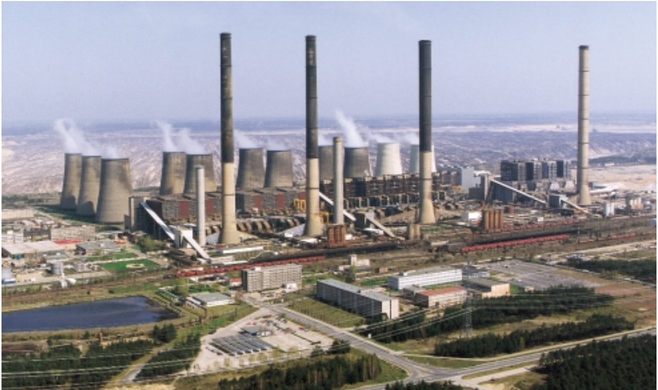
Rekonstruktion im 2 × 500-MW-Braunkohlekraftwerk Boxberg
