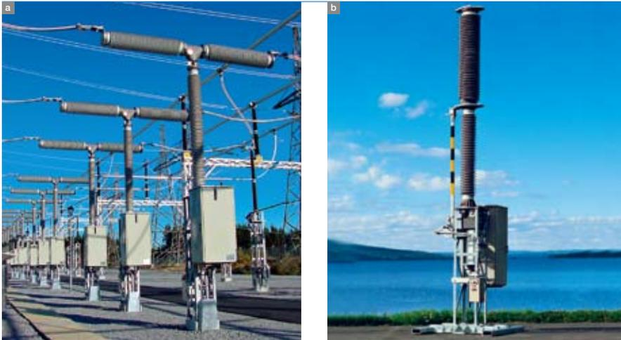
利用成熟的现代自能式及 / 或吹弧式 SF<sub>6</sub> 断路器，ABB 开发了既可简化变电站又能节省空间的替代方案。
