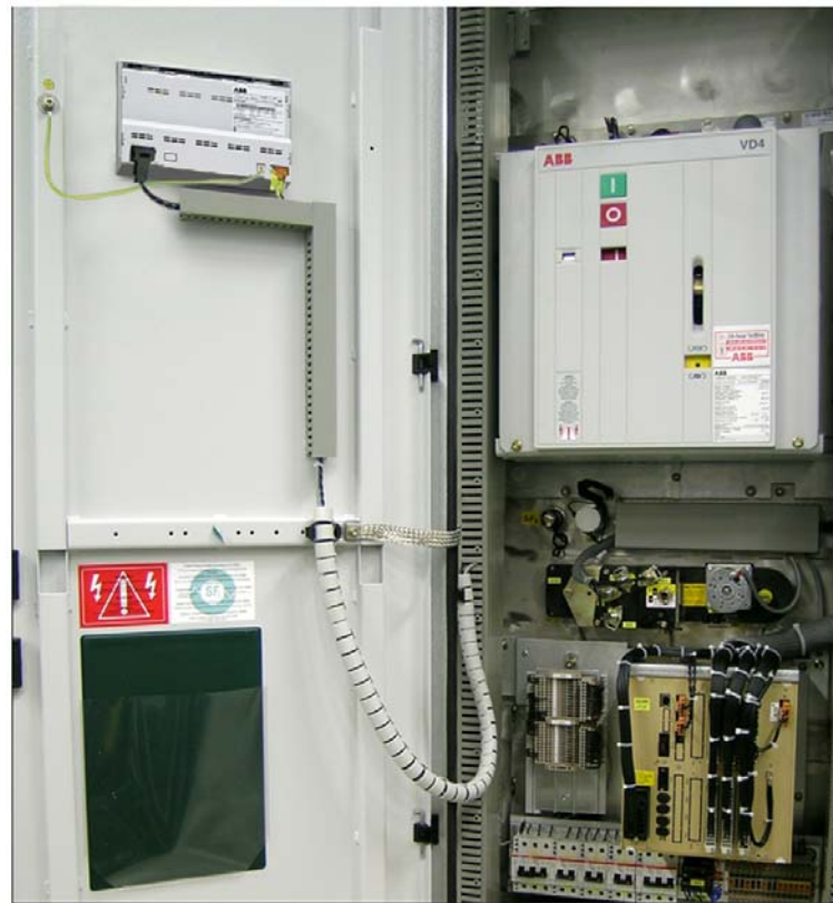
Fig. 3.-3 Montaje de la unidad central en el compartimiento de BT y de la HMI en la puerta
