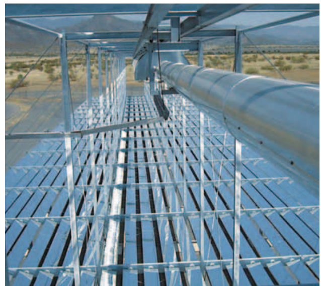
Abbildung B.7 - Anlage mit linearem Fresnel-Konzentrator
