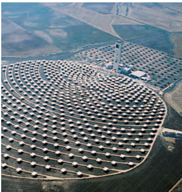
Abbildung B.8 - Anlage mit Zentralempfänger
