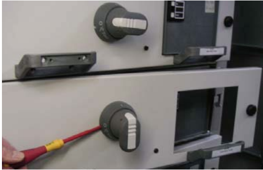
56 使用螺丝刀卸下抽出式抽屉的前面板
