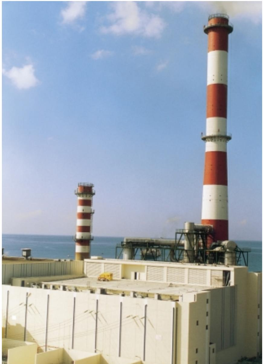
**Centrale diesel-électrique de Rhodes – elle comprend actuellement deux blocs de 12 MW et trois blocs de 24 MW.**
