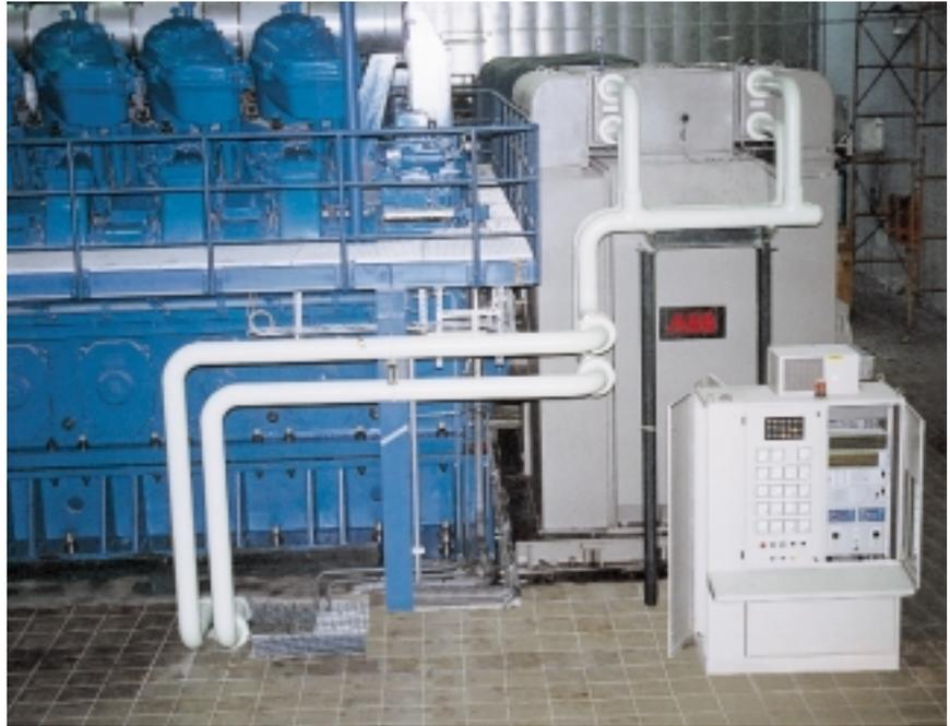
L'un des trois blocs d'alternateurs diesel de 24 MW
