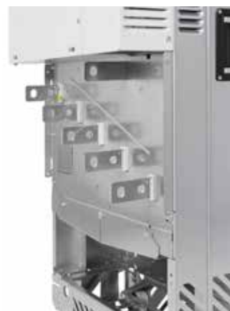
可选项+D150制动斩波器+连接母排
