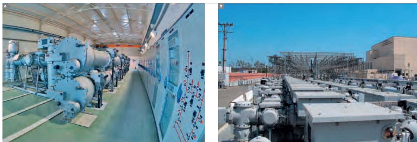
3 在西班牙（马略卡岛）装有ELK-04型GIS的典型变电站 a 及在美国（加利福尼亚州）的AIS被更换成ELK-04型GIS设备 b
