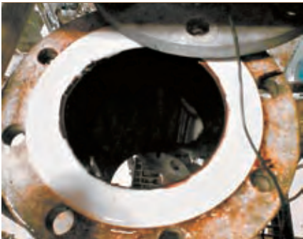
6 应用在纸浆和造纸工业中结垢的电磁流量计
