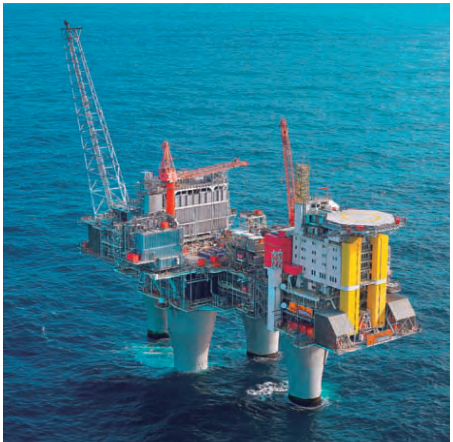
4 StatoilHydro 位于北海的海上天然气平台 Troll A
