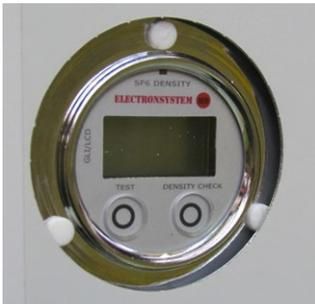
Измеритель плотности элегаза необходим для от- слеживания давления газа и для подачи аварийного сигнала, если давление становится слишком низким.
