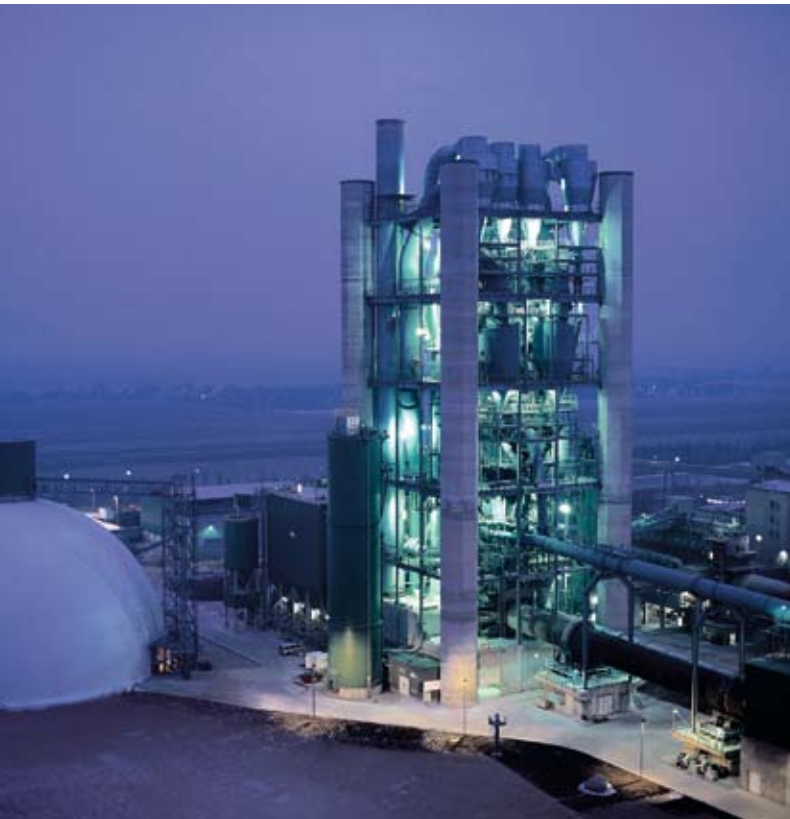
9 Holcim-Werk Lägerdorf, Ofenlinie 11 9 Holcim plant Lägerdorf, kiln line 11
