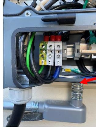
Installation d'un conduit de 31,75 mm (1,25 po) fixé à la zone de fixation inférieure. Version monophasée illustrée
