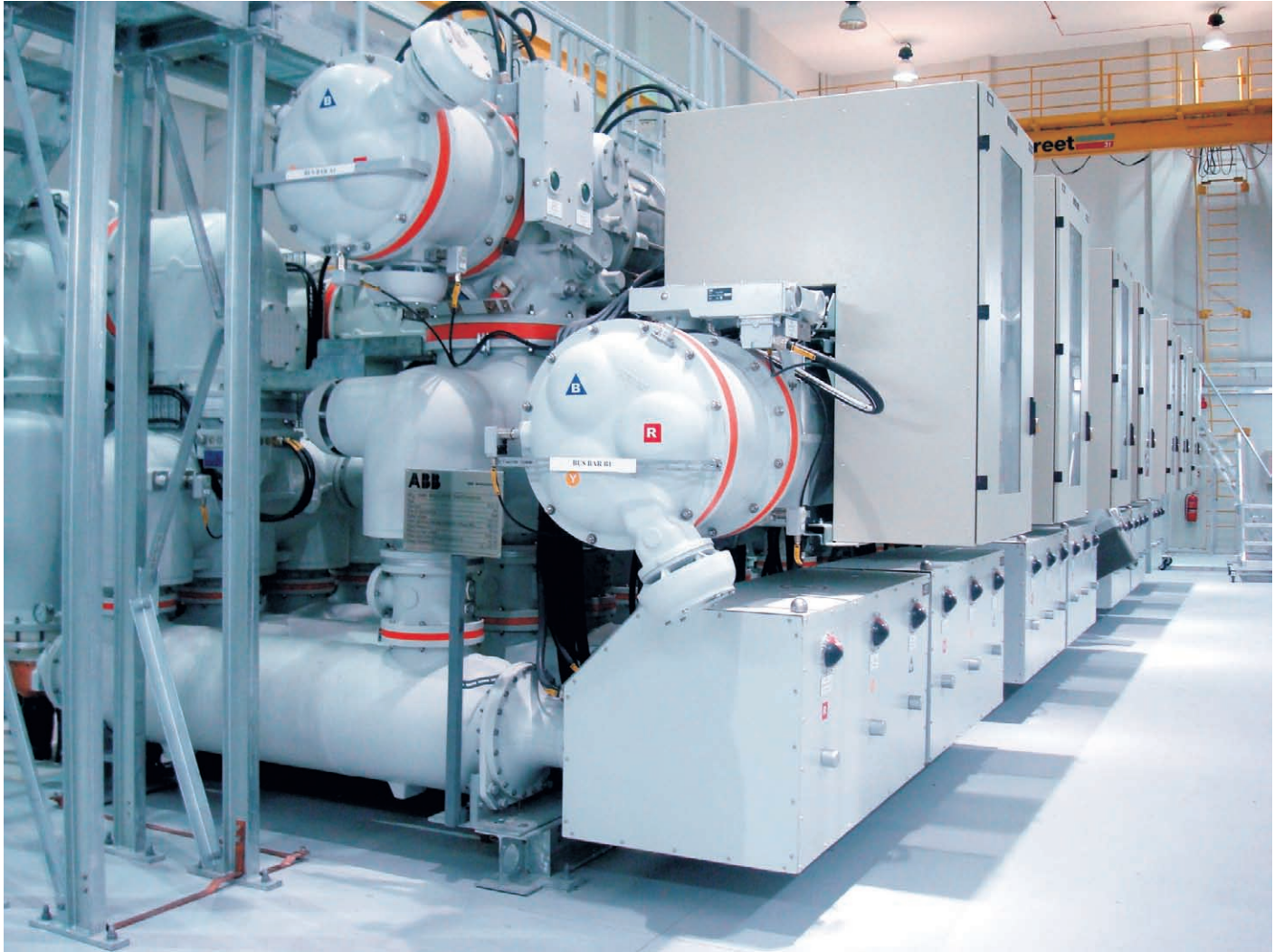
ELK-14 double busbar switchgear
