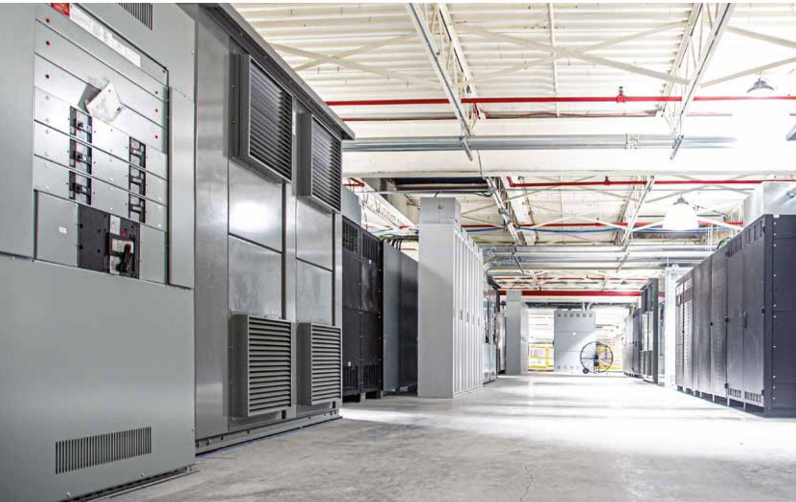
01 ABB y GIGA Data Centers desarrollaron una solución de electrificación de aparamenta de baja tensión, transformadores de tipo seco y SAI para dar soporte al servidor de TI y a la infraestructura de red de GIGA Data Centers.
