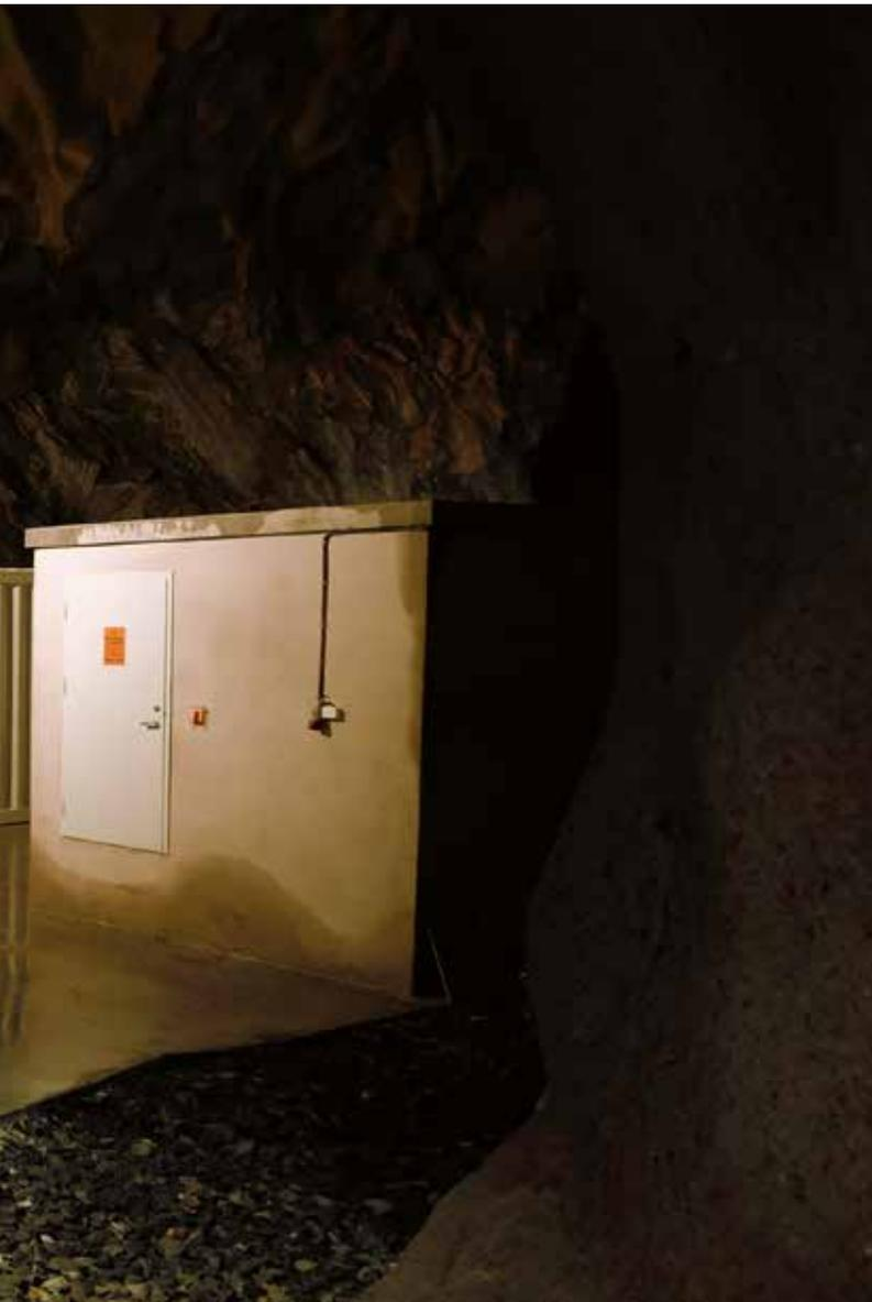
01 Ubicado en lo que una vez fue la mina de olivino más grande del mundo, el Centro de Datos de la Mina Lefdal es un emplazamiento de almacenamiento de datos de 120 000 m<sup>2</sup> basado en contenedores en Måløy, en la costa oeste de Noruega. El emplazamiento está diseñado para albergar hasta 1500 contenedores con un presupuesto de refrigeración de hasta 200 MW. En emplazamientos como este, la automatización de los centros de datos es indispensable.
