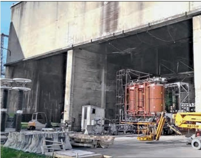
Le changeur de prises en charge sec est installé devant le transformateur, chaque phase ayant son unité. Il est configuré pour régler la tension dans une plage de +4/-12 %, par échelon de 1,25 %; la charge est commutée à l'aide d'interrupteurs à vide. Transformateur et changeur de prises sont clôturés pour éviter tout contact direct, mais ne nécessitent pas d'enveloppe de protection.
