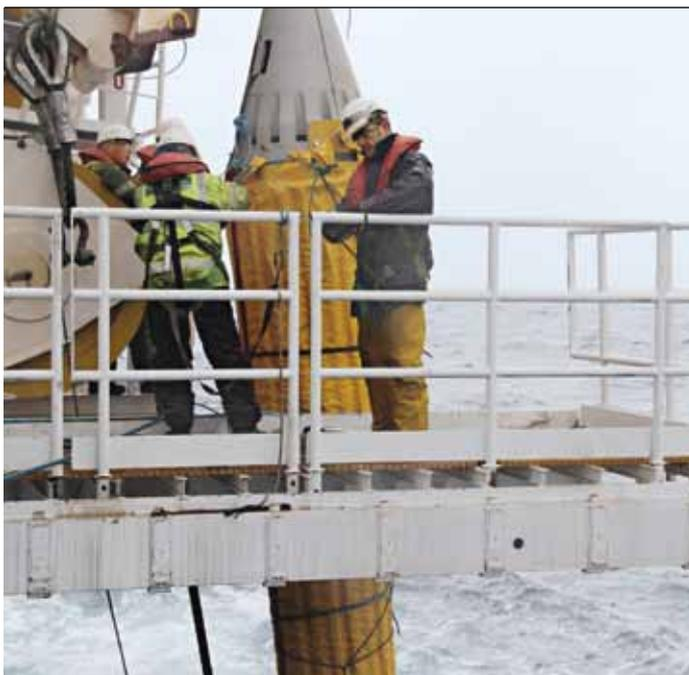
el riesgo de vibraciones inducidas por vórtices (VIV), se colocaron en el cable tracas de supresión<sup>2</sup>. Los tramos sin apoyo se resolvieron mediante la descarga de rocas.
