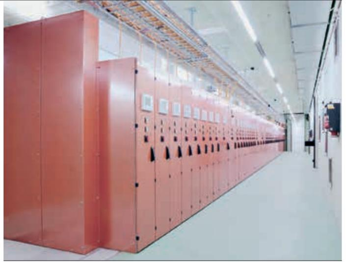
3b Mittelspannungs-GIS für 24 kV
