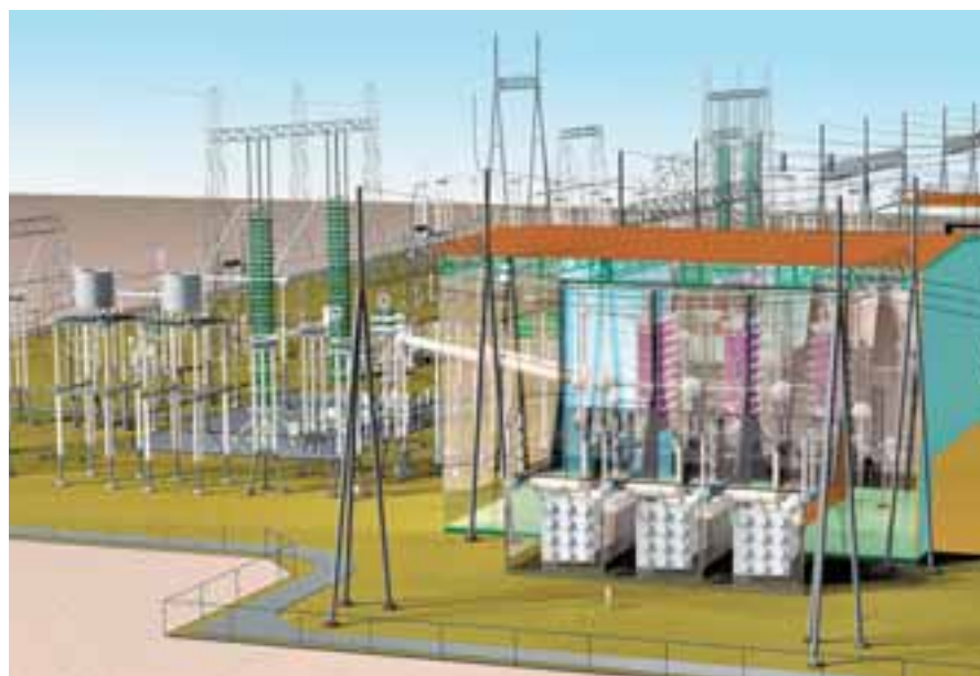
7 Преобразовательная подстанция с четырьмя силовыми блоками для ЛЭП постоянного тока – такая конфигурация выбрана для сведения к минимуму последствий выхода из строя отдельных компонентов.
