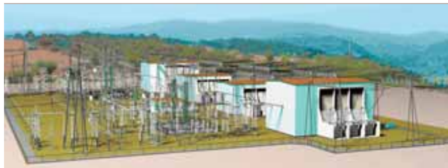
7 Преобразовательная подстанция с четырьмя силовыми блоками для ЛЭП постоянного тока – такая конфигурация выбрана для сведения к минимуму последствий выхода из строя отдельных компонентов.
