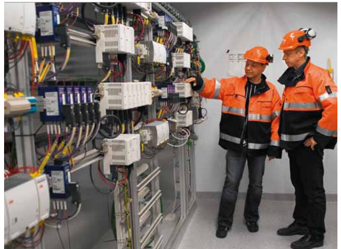
3 Controllers at the Östrand mill (Photo: Michael Berggren)
