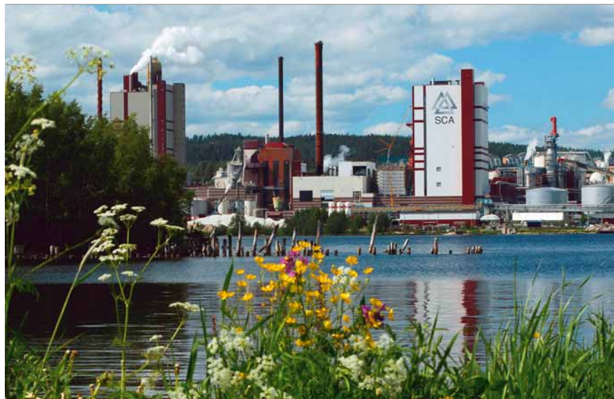
SCA's Östrand pulp mill, Sweden (Photo: Michael Berggren)
