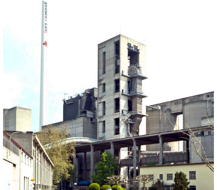
Zementwerk von Jura Cement in Wildegg, Schweiz
