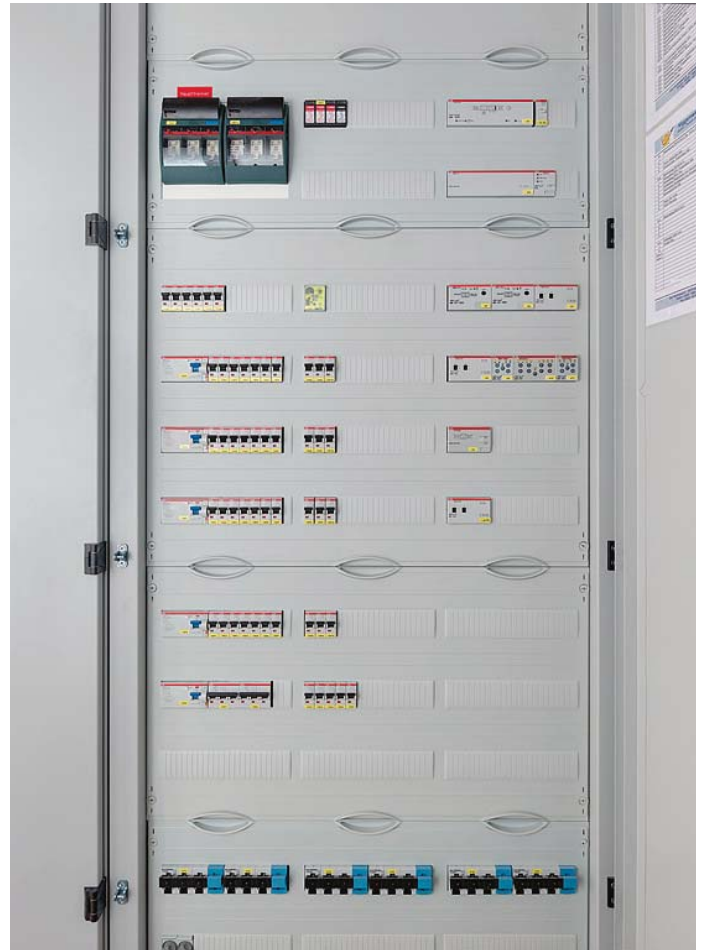
Das Herzstück: Intelligente Gebäudetechnik von ABB
