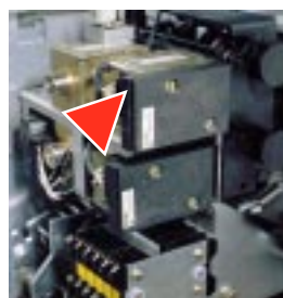
Sganciatore di minima tensione.
