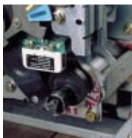
Motoriduttore carica molle.
