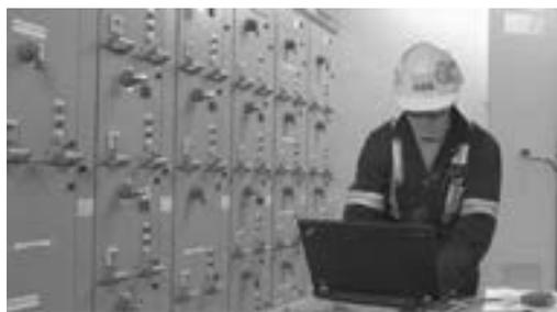
Se cuenta con un CCM Inteligente el cual utiliza el Controlador Avanzado de Motores UMC100.3 y todos los Arrancadores tienen la posibilidad de integrar los siguientes protocolos de comunicación:
