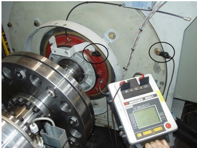
Figura 34 Medição da resistência de isolamento de um mancal de roletes
