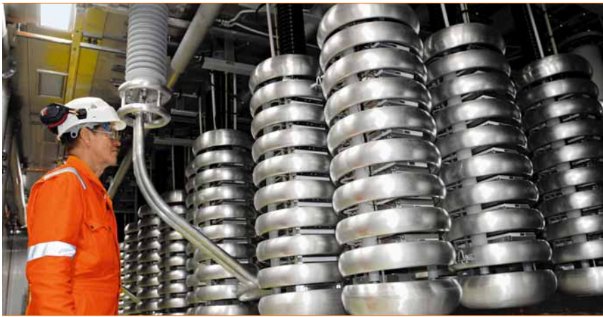
3 Válvulas IGBT, el corazón del convertidor
