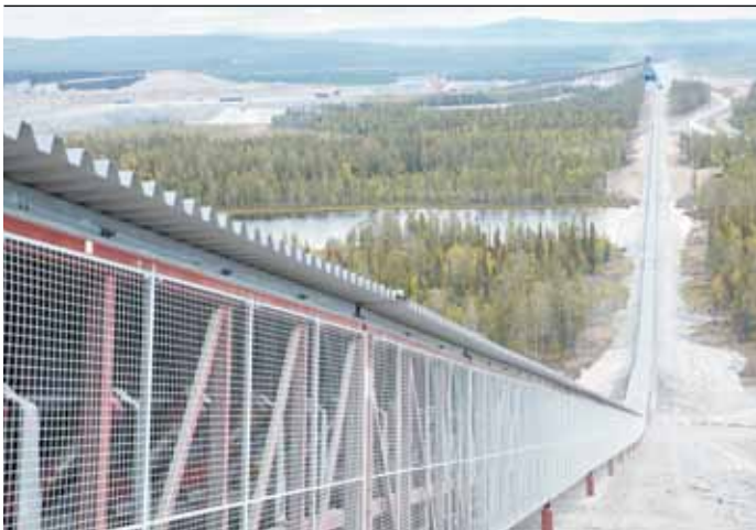
4 Приводы АББ установлены на 7-км конвейерах, которые транспортируют руду на концентратор в Аитике.
