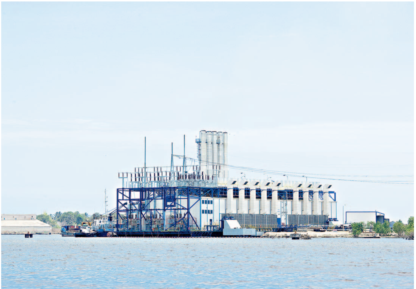
150 MW power barge Sultana del Este in the Dominican Republic
